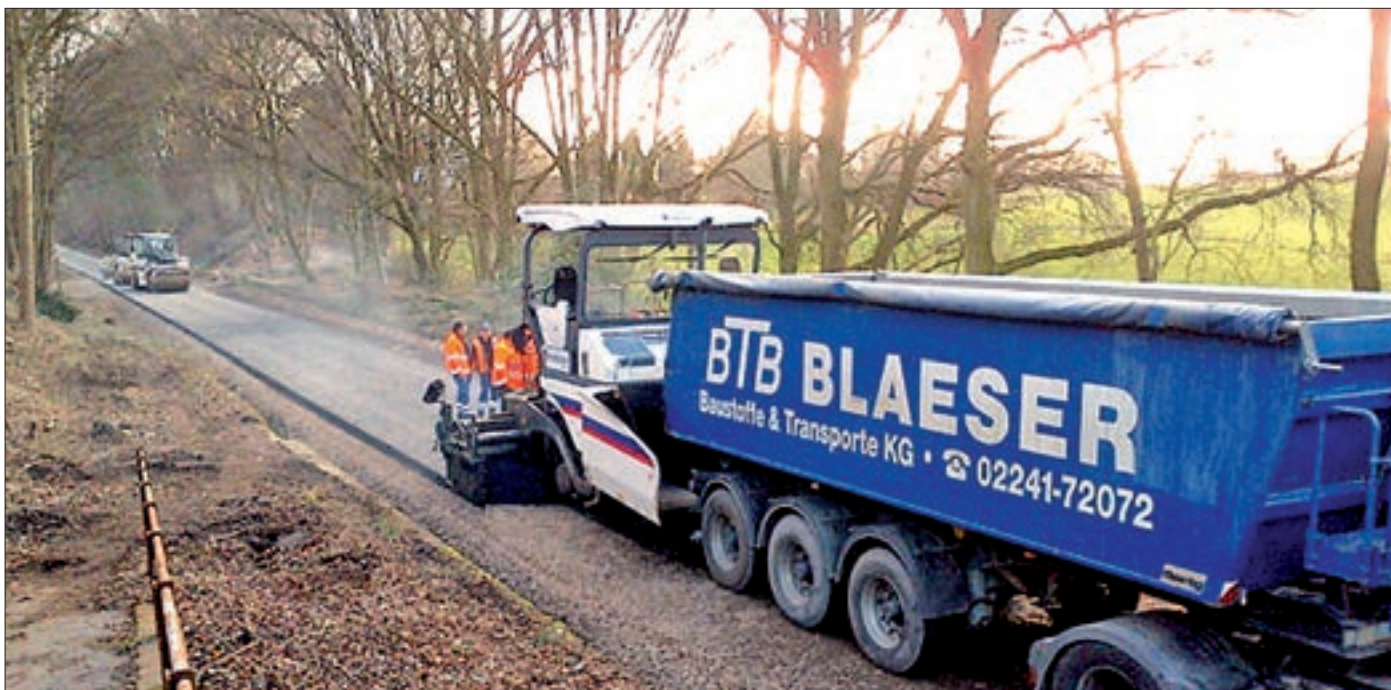
Der Leverkusener Abschnitt der Balkantrasse wird zurzeit asphaltiert.
